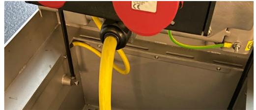
Si le Campetto n'est plus utilisé, le coulisseau remis en place doit être réglé en conséquence à l'ouverture de la sortie du câble avant la fermeture.
